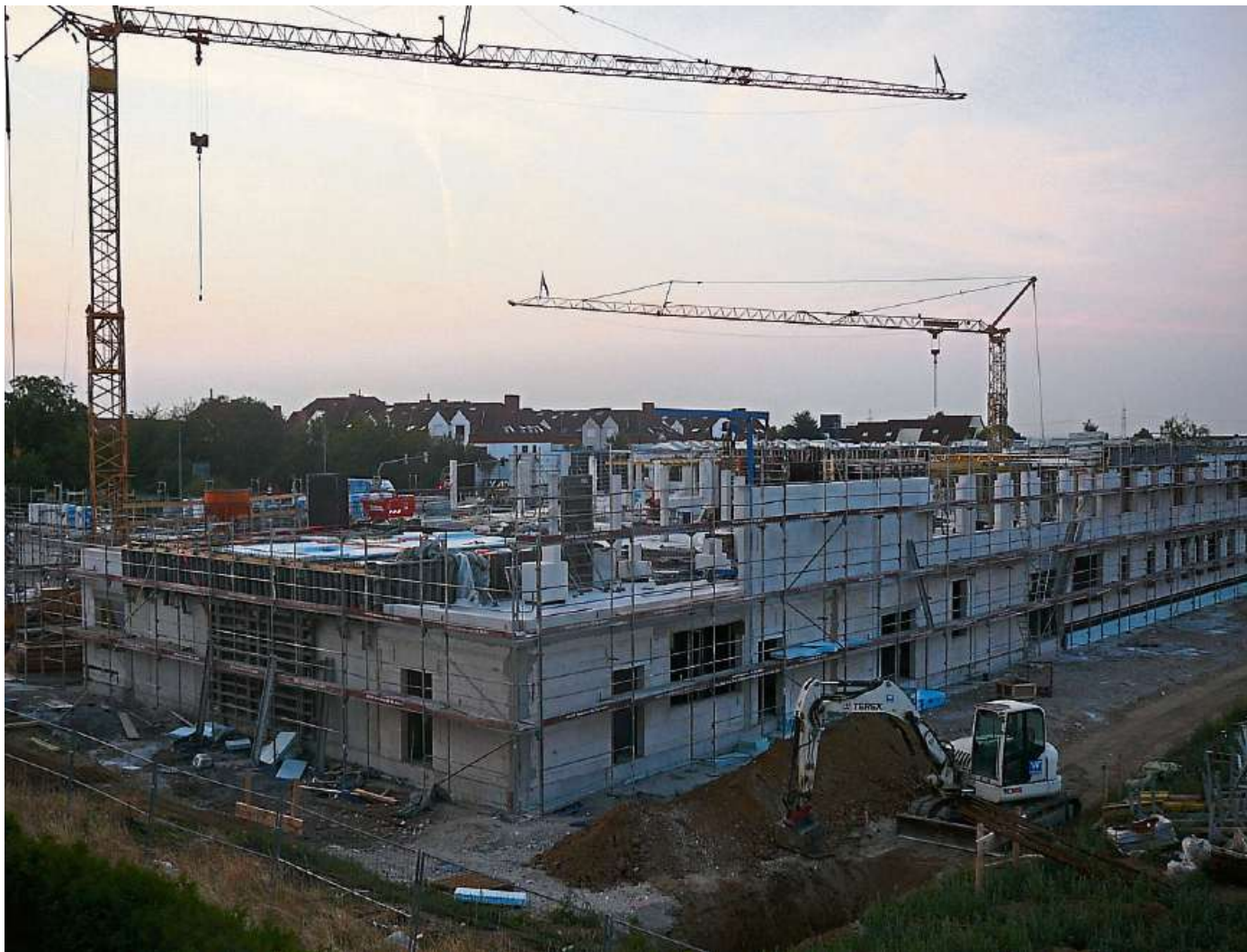
Das neue Gebäude der Tierklinik nimmt mehr und mehr Formen an. Bereits am 11. September soll Richtfest gefeiert werden. Foto: Kirsten Weber
